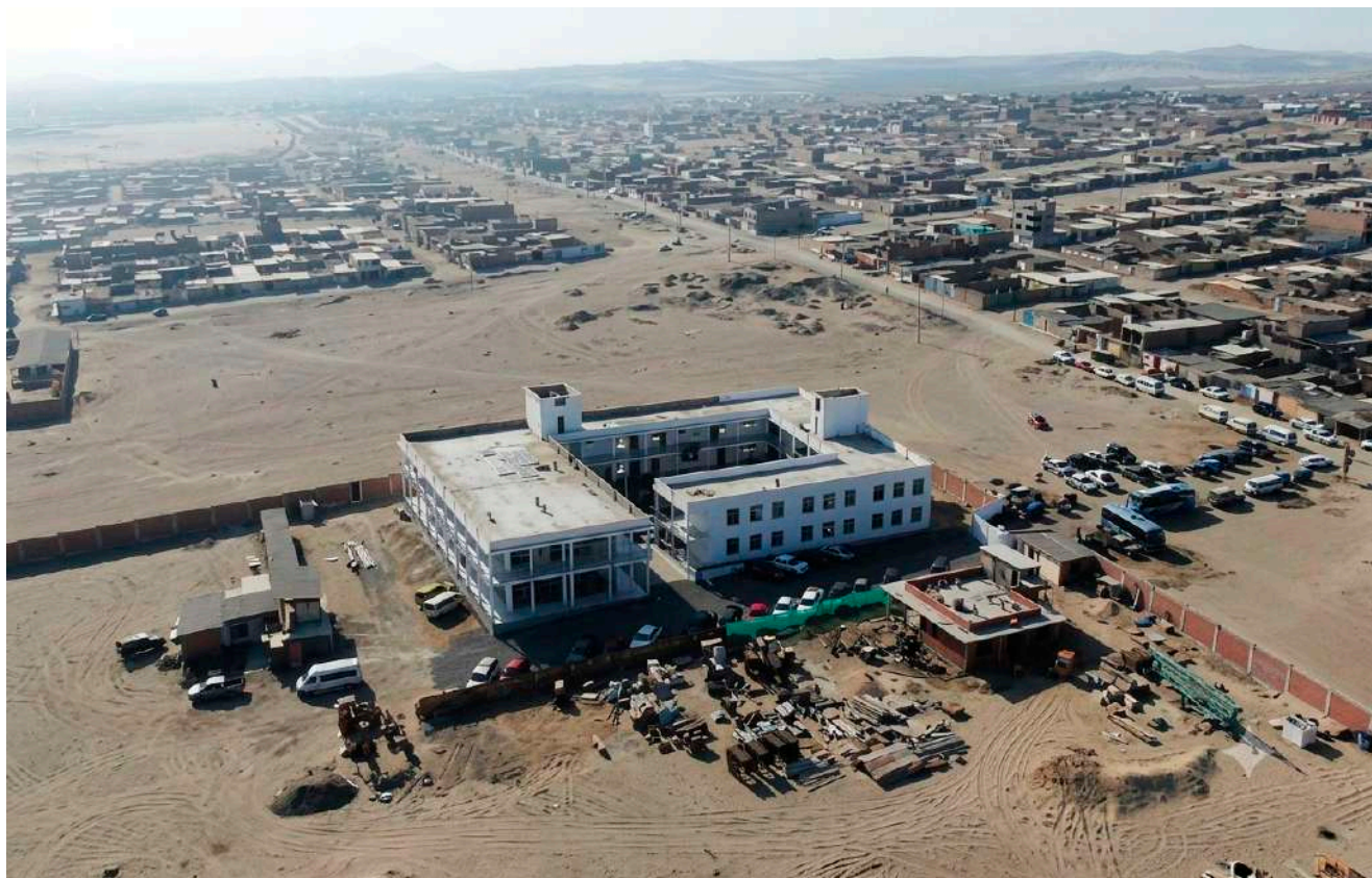
Complejo educativo edificado por la Organización Mato Grosso en Nuevo Chimbote.
