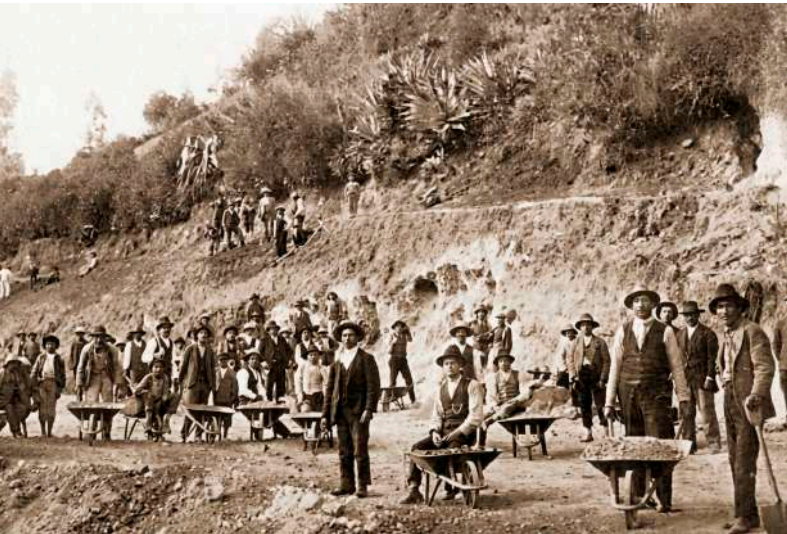
Entre los años 1920 y 1930, se construían las carreteras con lampas, barretas, picos y carretillas, por la inexistencia de maquinarias. Participaba toda la población, en cumplimiento de la Ley Vial
