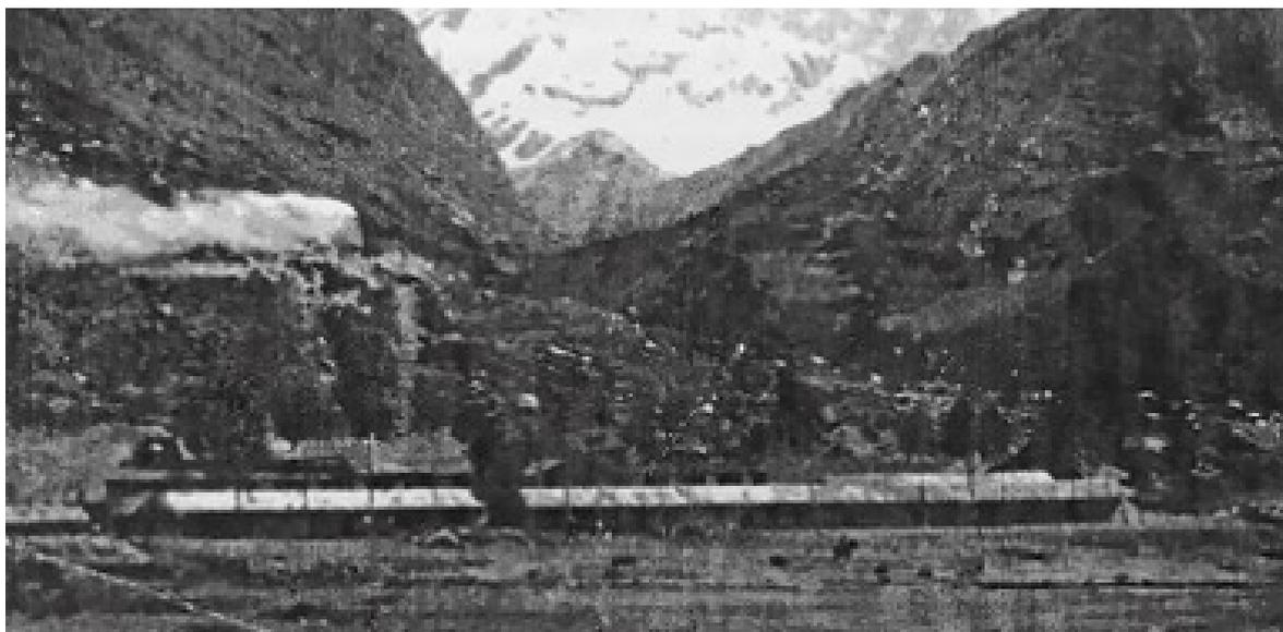
*Fundición de plomo y plata en Vesubio en su “Época de Oro” con la chimenea emitiendo humo, vigente hasta los finales de la década del cincuenta del siglo pasado. Después, modificaron la tecnología para procesar el concentrado del mineral al sistema de “flotación”*
