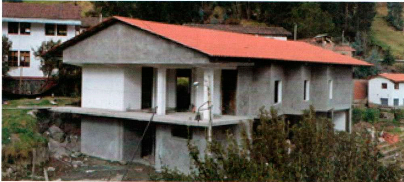
Actual pabellón: gimnasio y auditorio casi concluidos
