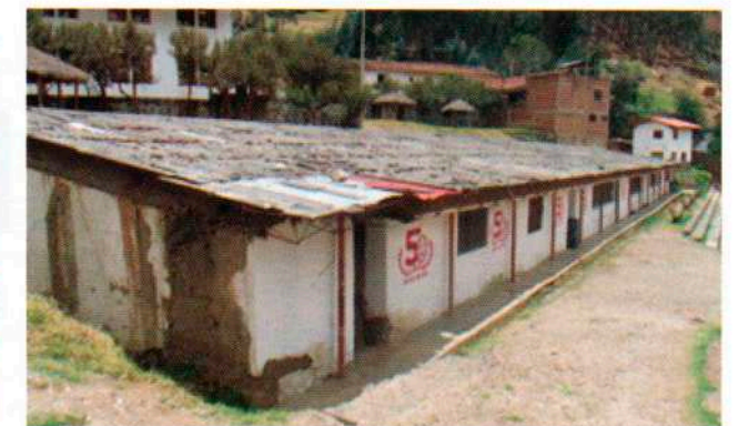
Anterior pabellón, derruido para la nueva edificación
