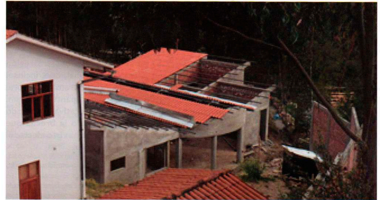
Comedor escolar, en pleno techado
