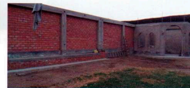
Parte del nuevo muro lateral, con el fondo de la futura capilla
