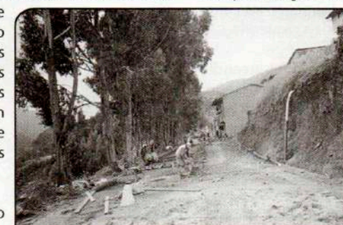
La vista muestra los trabajos correspondientes a la prolongación del jirón Buenos Aires, desde el barrio La Alameda hacia el sector de Pirushu.
