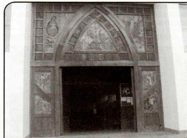
La formidable puerta principal de la catedral de Pucallpa, tiene un diseño definitivamente moderno; pero sus artísticos tallados en alto relieve delatan la intervención de sus autores: Los artesanos chacasinos.
