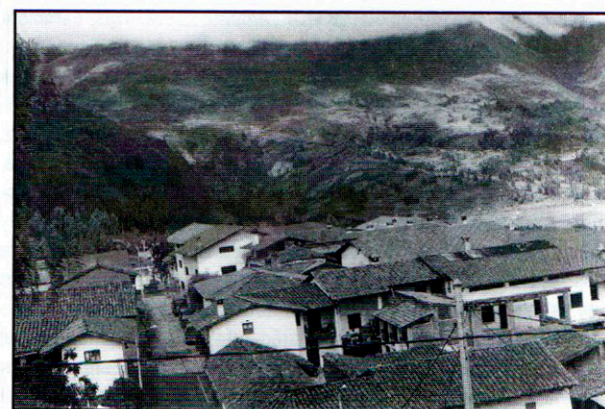
El actual servicio de agua para consumo humano no es "potable" en Chacas, solamente es "entubada"; la constante expansión urbana exige la implementación de este servicio y el del alcantarillado.
