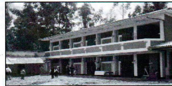
En la actualidad el Estado, a través de la Municipalidad del Distrito de Acochaca, ha construido seis aulas con material noble, conforme se aprecia en la fotografía.
