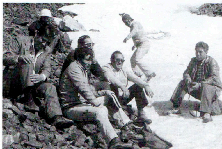
Una visita a los trabajos de la carretera Carhuaz-Chacas (1979).
