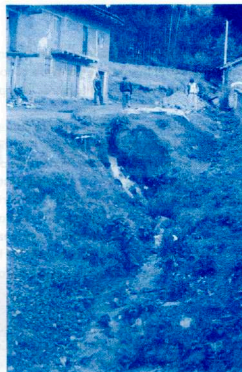
SISTEMA DE ALCANTARILLADO Descarga Libre de Desague en acequia local
