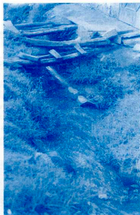
SISTEMA DE ALCANTARILLADO Descarga Libre de Desague en acequia local
