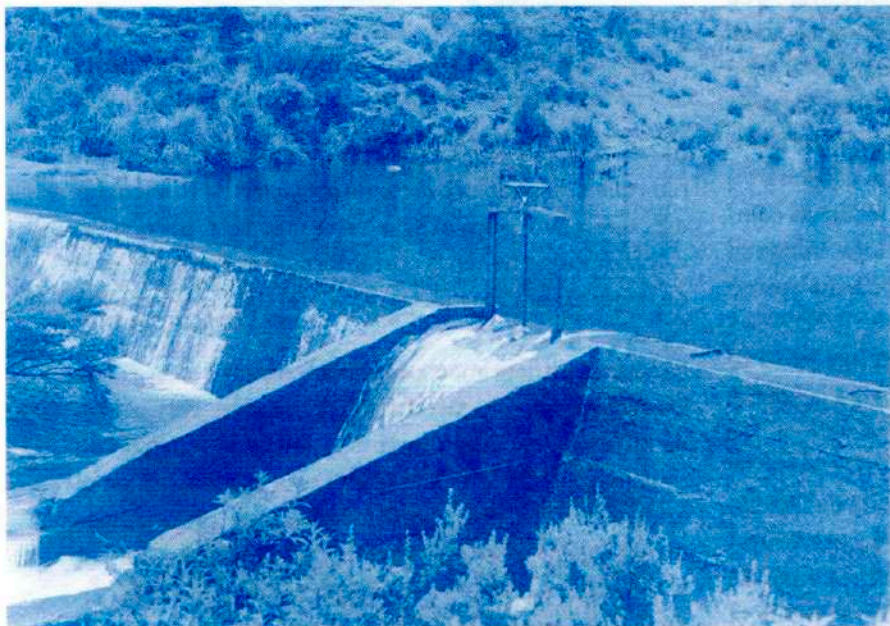
Laguna Patarcocha - Captación
