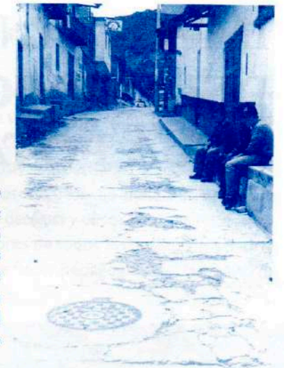
Estado deplorable de la pavimentación de una de las cuadras de Jirón Buenos Aires, pese al poco tiempo transcurrido.
