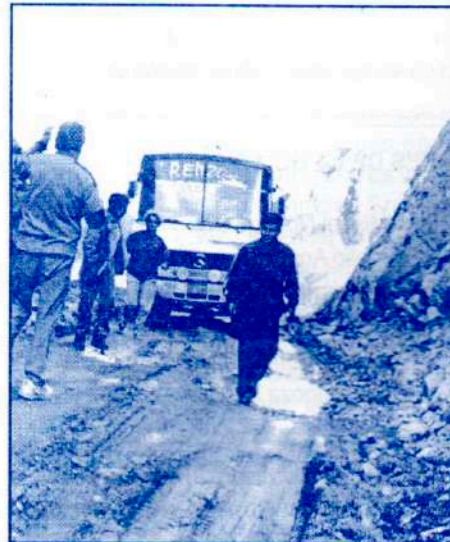
Es necesario un perfil (como requisito mínimo) del mejoramiento del tramo carretero Carhuaz - Chacas - San Luis. Se observa el deplorable estado de la vía en su sector de mayor altitud.
