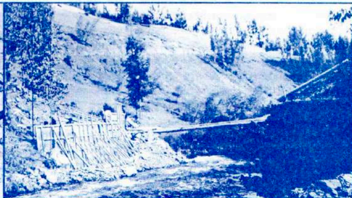
Puente de Cashashuy en la carretera a Macuash.
