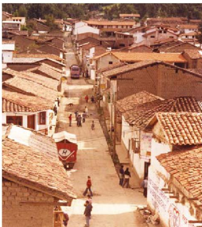
Una de las obras de la que no se rindió cuenta en la anterior administración edil, fue la millonaria inversión en la pavimentación del Jirón Buenos Aires, en la que innecesariamente se malgastó prologándola hasta "Pirushito", porque ya estaba en el proyecto de la carretera asfaltada.
