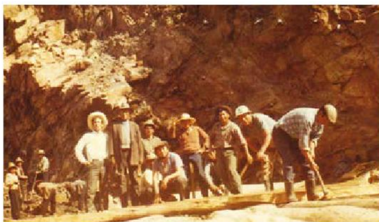
Los trabajadores de la Corporación Peruana del Santa colaboran en la construcción del primer puente carretero en Chacapata, abril 1972; están Misael Noriega (regidor), Enrique Amez (alcalde), Lizardo Cauzo, Washington Morales, Samuel López (regidor), Luis Amez, Lizardo Cauzo, Isaias Zaragoza, entre otros.
