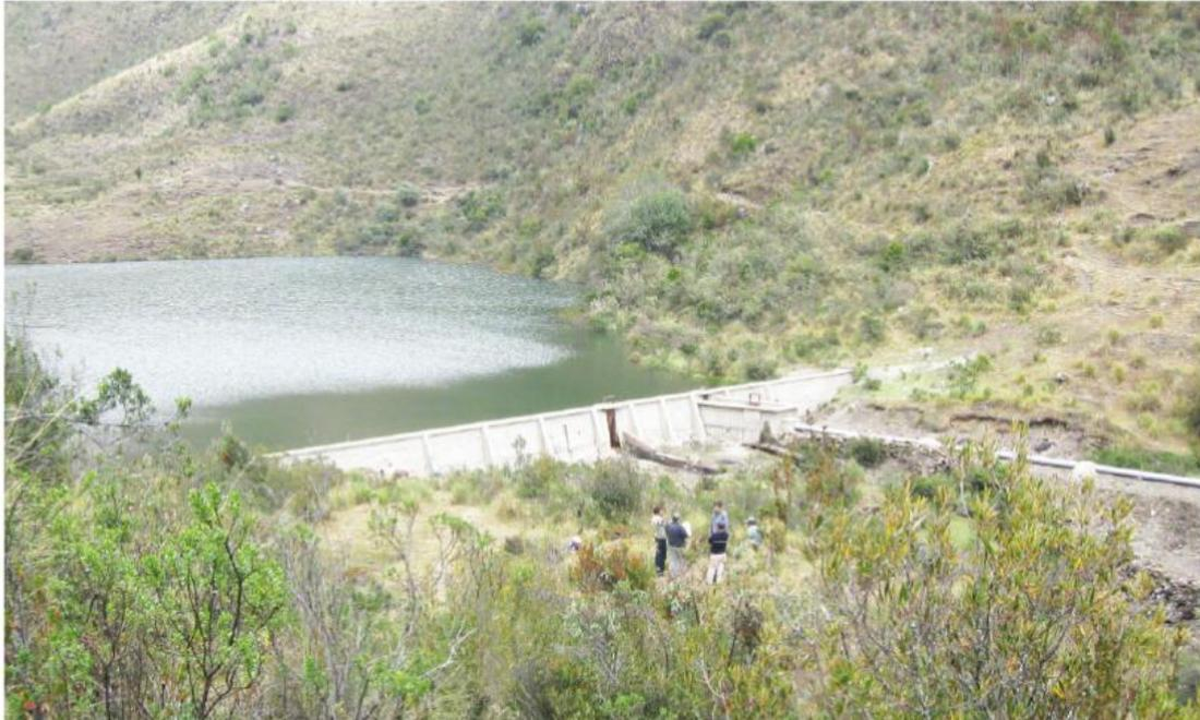
Esta instalación de la captación del agua para Chacas en la laguna de Patarcocha, se encuentra **fuera de servicio** por deficiencias técnicas, ya que en tiempo de estiaje el agua queda por debajo del nivel de las tuberías, volviéndolas inoperativas.
