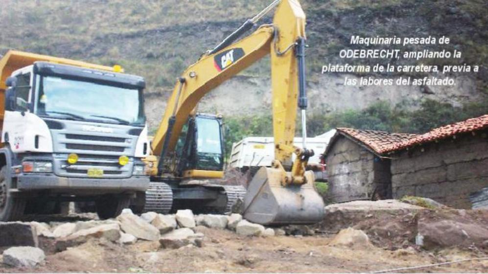
Maquinaria pesada de ODEBRECHT, ampliando la plataforma de la carretera, previa a las labores del asfaltado.
